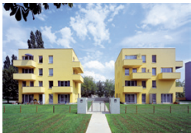
Segmentabbriss und Umbau zu Stadt villen Leinefelde
