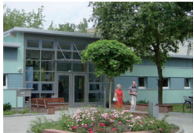
Umbau von Kiko zu Gemeinwesenzentrum Cottbus
