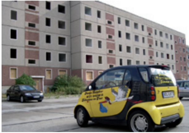
Entkernter Wohnblock für Abriss Leipzig
