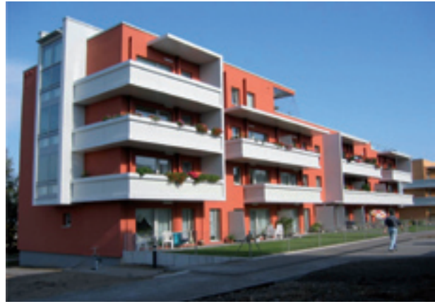
Geschossrückbau/Umbau Dresden, Kräutersiedlung
