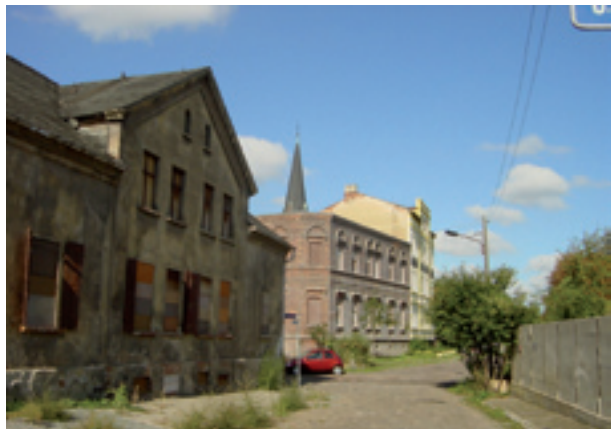
Stadtrand Verfall von Altbausubstanz Magdeburg
