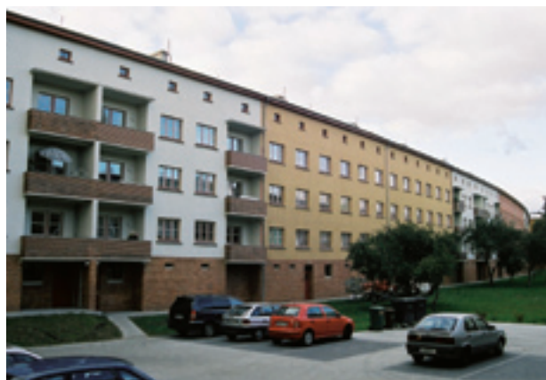
Sanierte Zeile der 20er Jahre Magdeburg
