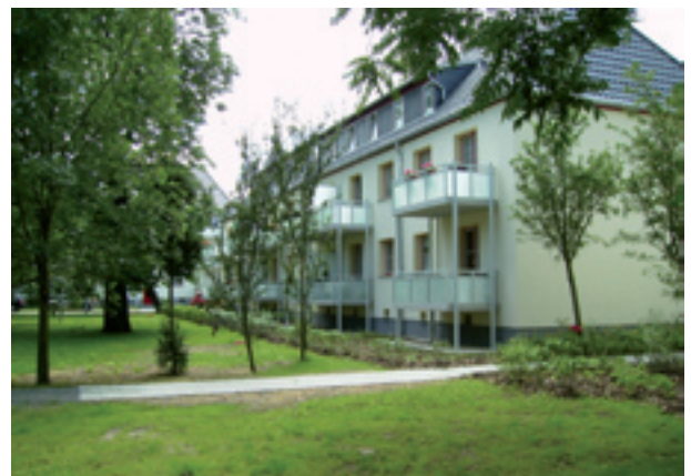
Saniertes Werksiedlung der 30er Jahre Wittenberg
