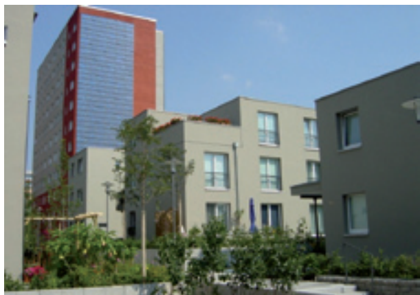
Hochhausanierung und Umbau zu Stadt villen Cottbus
