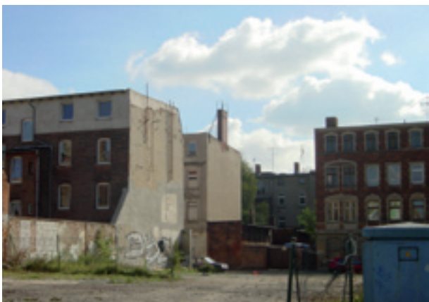
Erodierende innerstädtische Altbaustruktur
